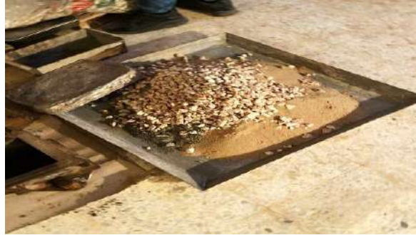
الشكل (6): تجهيز مكونات الخلطة الخرسانية قبل الصب.
