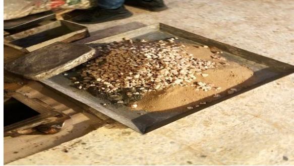
الشكل (6): تجهيز مكونات الخلطة الخرسانية قبل الصب.
